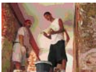
Murerlæringer i Fort Frederik, 2004.
