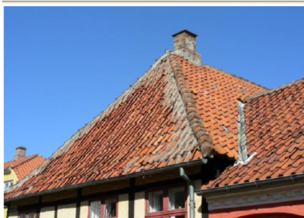
Gammelt understrøget tag, delvis forskellet.
