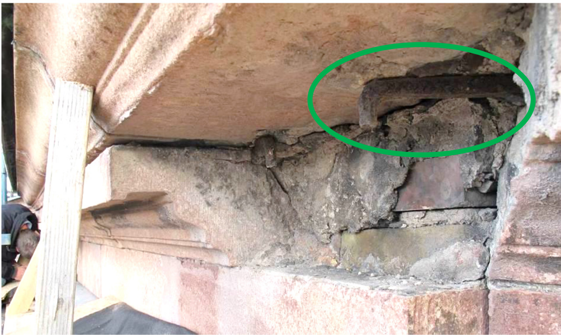
Fig. 81. Taklist av natursten med tyngdpunkten liggande innanför murlivet.
