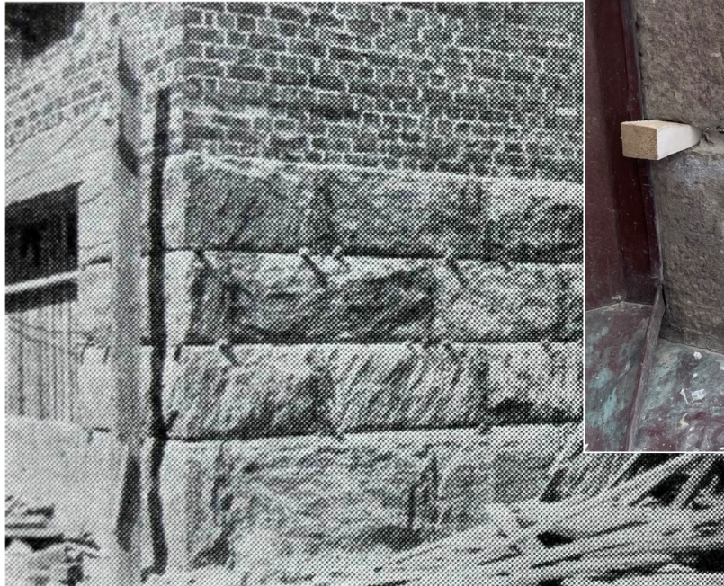
Träkilar under blocken vid montering. Figur ur: Bugge, Andreas. Husbygninglaere. 1918, s. 202. Fotografi ur: Hökerberg, Otar (red.). Byggteknik II:1. 1959, s. 264.
