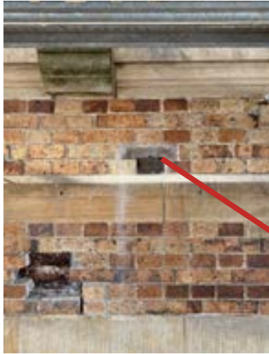
PROV 2 (Sättbruk murverk)
