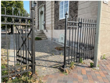
Staket- och grindsektion närmast byggnaden har renoverats före återmontering.
