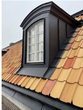
Takkuporna har klätts om i sin helhet med zinkplåt som platsmålats. Utseende och profilerings lika befintligt.
