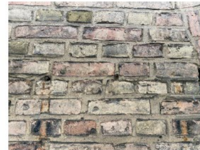
Befintlig stevskuren åsfog.
