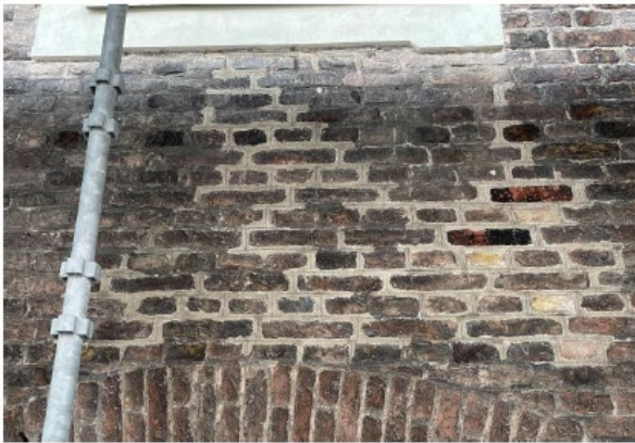
Exempel på fogkomplettering i ursprungligt murverk, ritsad fog som patinerats med pigmenterat kalkvatten.
