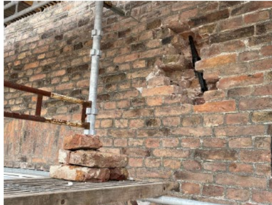
Inmurade ankarjärn har identifierats och kontrollerats. Alla var i gott skick och behövde varken bytas ut eller förses med offeranod.
