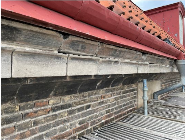
Rengjord takfotsgesims. Den svarta förgipsningen tas inte bort.
