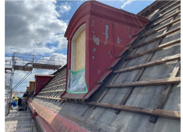
Befintlig takkupas utseende har återskapats i detalj.
