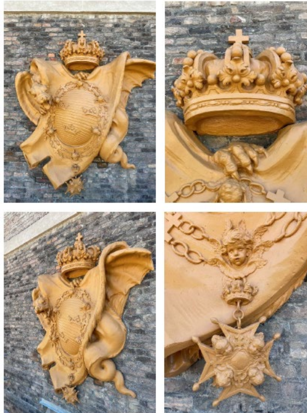
Kartuschen har demonterats och genomgått en grundlig restaurering. Den har monterats i ursprungligt läge. Kartuschen har målats med linoljafärg, guldockra.
