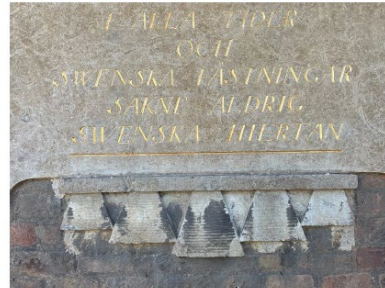
Detaljbild efter konservatorsrenigöring av stentavlan samt omfärggilling.
