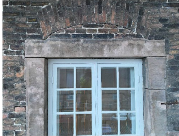
Portal justerad, dubbad och konserverad.
