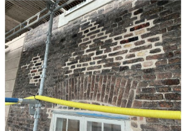
Fogkomplettering med ritsad fog, före patinerings.
