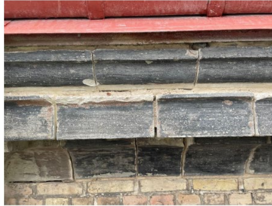
Gipsstenen är en konststen som prefabricerats, möjligtvis i Tyskland. Det är ovanligt att finna gipssten utomhus i en byggnad i vårt utsatta klimat. Ganska kort efter uppförande bildades den svarta krusten, som finns kvar över stora delar av gesimsen.
