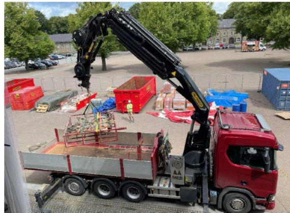
Kartuschen kunde därefter lyftas ner och transporteras till verkstad. På detta vis har den säkert kunnat förflyttas mellan verkstad hos Prosvede i Hörby och BM Plåt i Lomma, där restaureringsarbetet har utförts.
