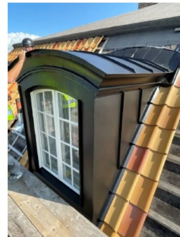
Provkupa vid normerande besiktning.
