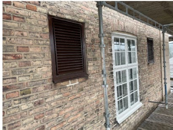
Bevarad ursprunglig fogyta i den påbyggda tredje våningen, fasad mot norr.
