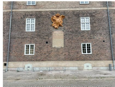
Renigöring/konservering och omfärggilling av stentavla med inskriptioner.
