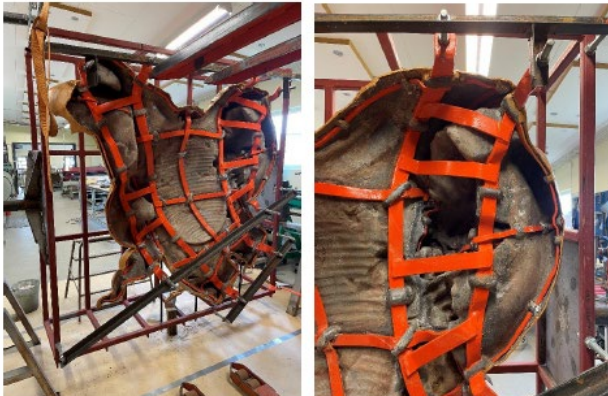
2024-04-24. Ursprungligt smidesskelett har behållits, blåsträts och kompletterats med nya delar. Därefter strukits fem gånger med äkta blymönja, innan det återmonterades med blypuckar.
