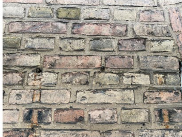
Bevarad slevskuren åsfog i tredje våningen.
