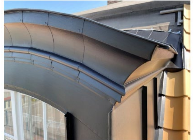
Plåtarbetet är utfört med stor noggrannhet.
