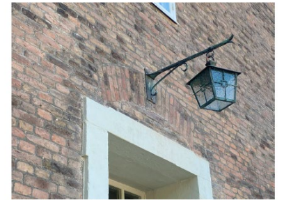
En av två lyktor i norrfasaden återmonterats. Även kopparlyktan i sydfasaden har satts på plats, sedan upphängningen renoverats.
