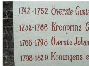
Ommålning av putstavlan i västfasaden utfört med linoljefärg, kulor
