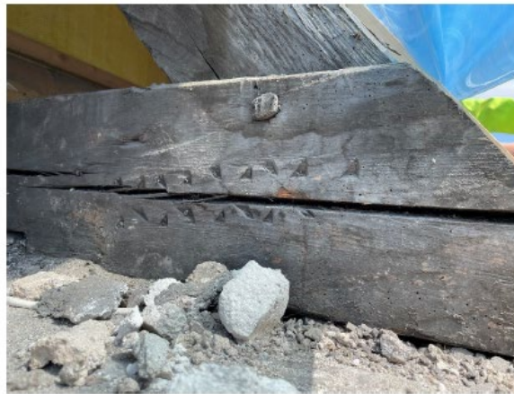
Timmermärkning på intakt del av takstol.
