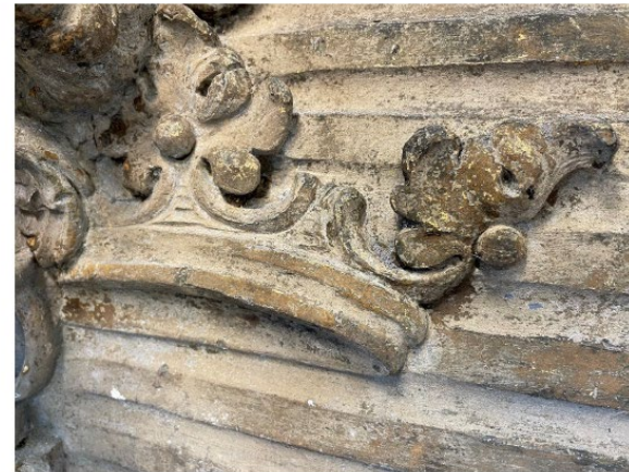
Färgfragment på kartusch efter färgborttagning.
