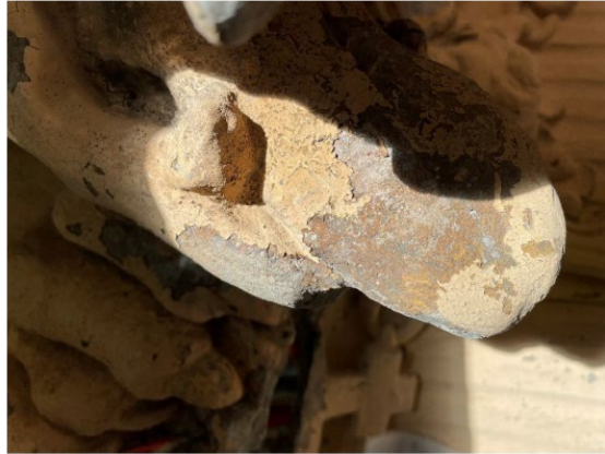
Spår av kraftig gul, övermålad med rödbrun kulör. Före kemisk rengöring med ES. Färgspåren syns fragmentariskt över hela kartuschytan, som därför förmodas alltid ha varit monokrom.
