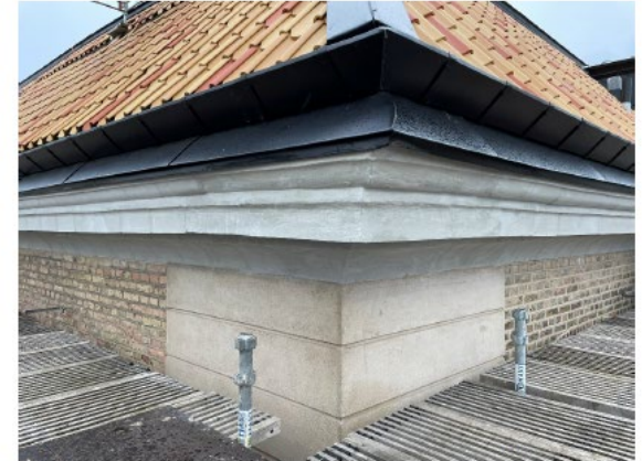
Takfotsgesimsen utgörs i ytter- och innerhörn (plus några sträckor till) av återanvänd originalsten från 1750-talet, som flyttades upp i samband med påbyggnaden 1874. Materialanalys visar att den ursprungligen varit kalkfärgad, med grå pigmentering, vilket har återställts.
