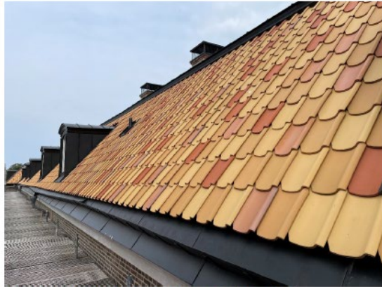
Fotrännan sedd från ovan. Nytt tegeltak i mansardtakets nedre del.
