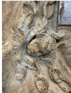
Kartuschen undersöktes noggrant för att se om det fanns äldre färgspår som tydde på att den varit målad i flera olika färger. Enbart äldre spår efter kraftig gul respektive rödbrun kulör framkom.
