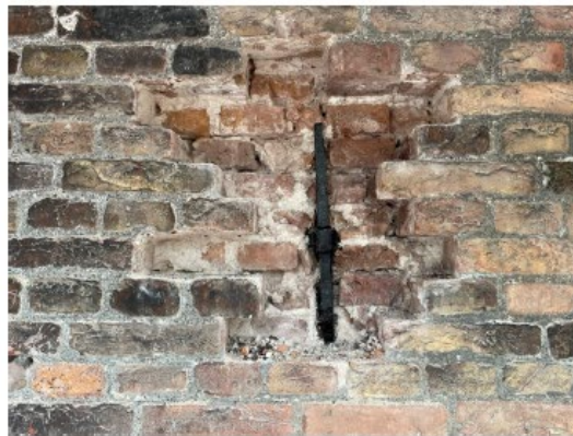
Synliggjorda och kontrollerade ankarjärn har rostskyddats och målats före igenmurning.
