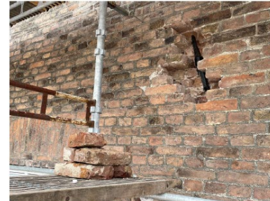
Inmurade ankarjärn har kontrollerats, alla var i gott skick och behövde varken bytas ut eller föres med zinknod.
