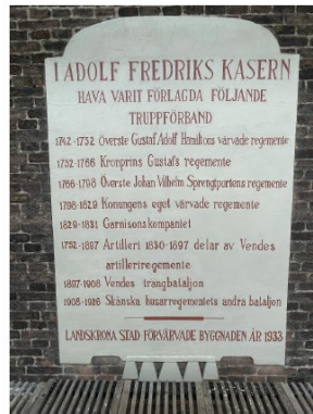
Ommålning av putstavlan i västfasaden utfört med linoljefärg, kulor
