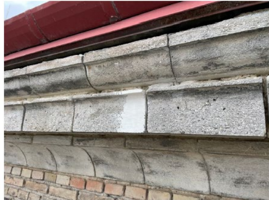
Gipsstenen är murad i tre skift. I vissa partier tycks det ha gjorts försök att blåsa bort den svarta förgipsningen.
