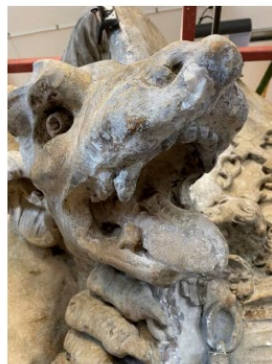
Kartuschen undersöktes noggrant för att se om det fanns äldre färgspår som tydde på att den varit målad i flera olika färger. Enbart äldre spår efter kraftig gul respektive rödbrun kulör framkom.
