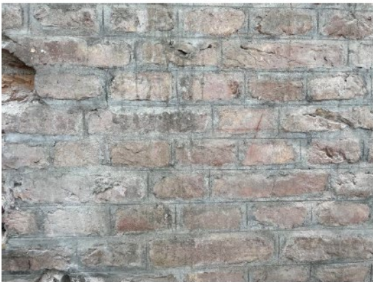
Den ritsade ursprungliga fogen påträffades i murverket där kartuschen suttit.
