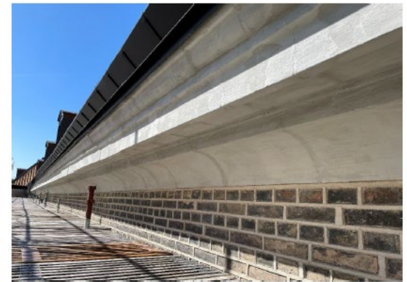
Takfotsgesimsen utgörs med undantag av naturstenshörnerna av prefabricerad gipssten, som är murad i tre skift. Inga infästningar av järn förekommer.
