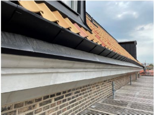
Fotrännan har utförts snarlikt befintligt med specialtillverkade rännkrokar.
