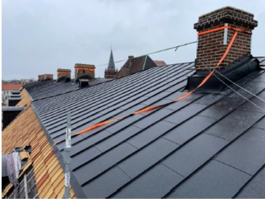
Omlagd plåt i mansardtakets övre del, skivtäckning lika befintligt. All takplåt är utförd med fabrikslackerad aluminiumplåt. Skorsten längst i väster är enbart omfogad, övriga skorstenar ommurade med bibehållet utseende.
