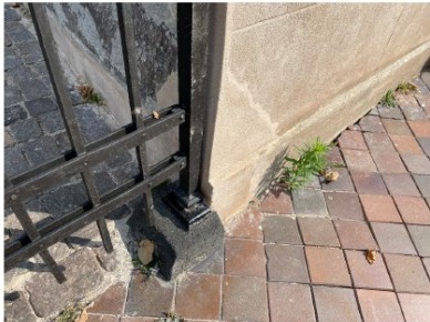
Beifintligt gütet fundament av betong fick behållas eftersom det vid närmare undersökning hänger ihop med betonggjutning under hela hörnet. Har patinerats för att efterlikna naturstensfundament i resten av staketet.
