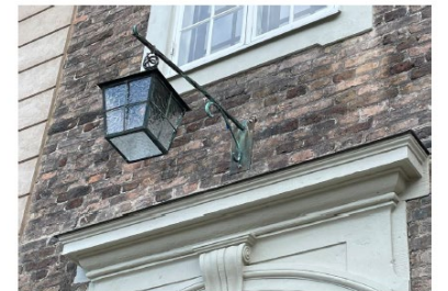
Lyktan över entrin i väster har renoverats och återmonterats.
