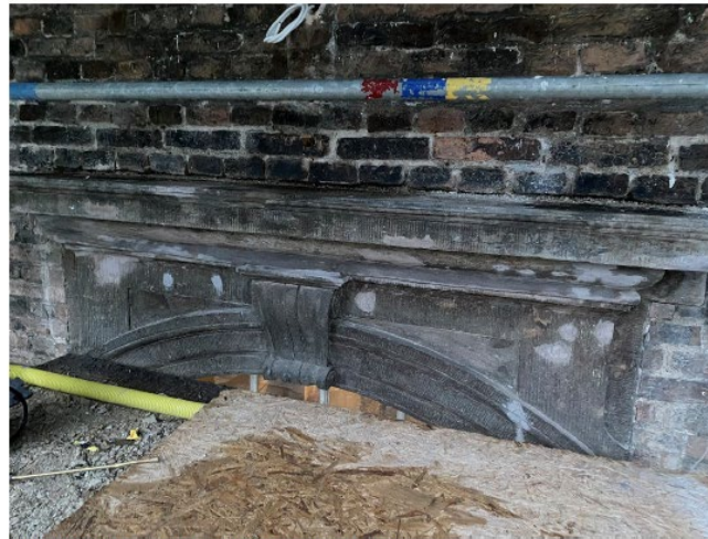
Portalöverstycke i väster, konservering slutförd.
