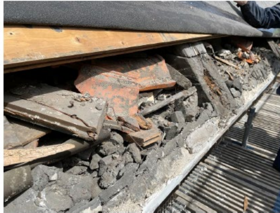
Underbrädningen nere vid takfot har öppnats upp och städats från bråte.
