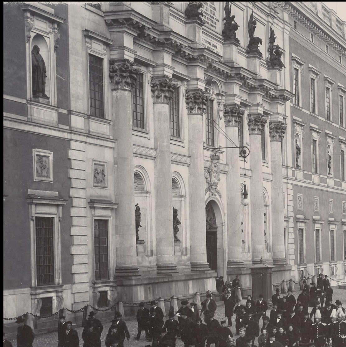
1907. Ny puts, komplettering av skulpturer i zink och brons, mezzaninfönster ersatts med relieftavlor i brons
