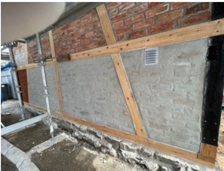
Tynnpuss trykket på og kostet ut i villstrykning.
