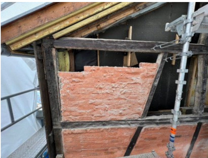
Demontering av tegl fag for fag.
