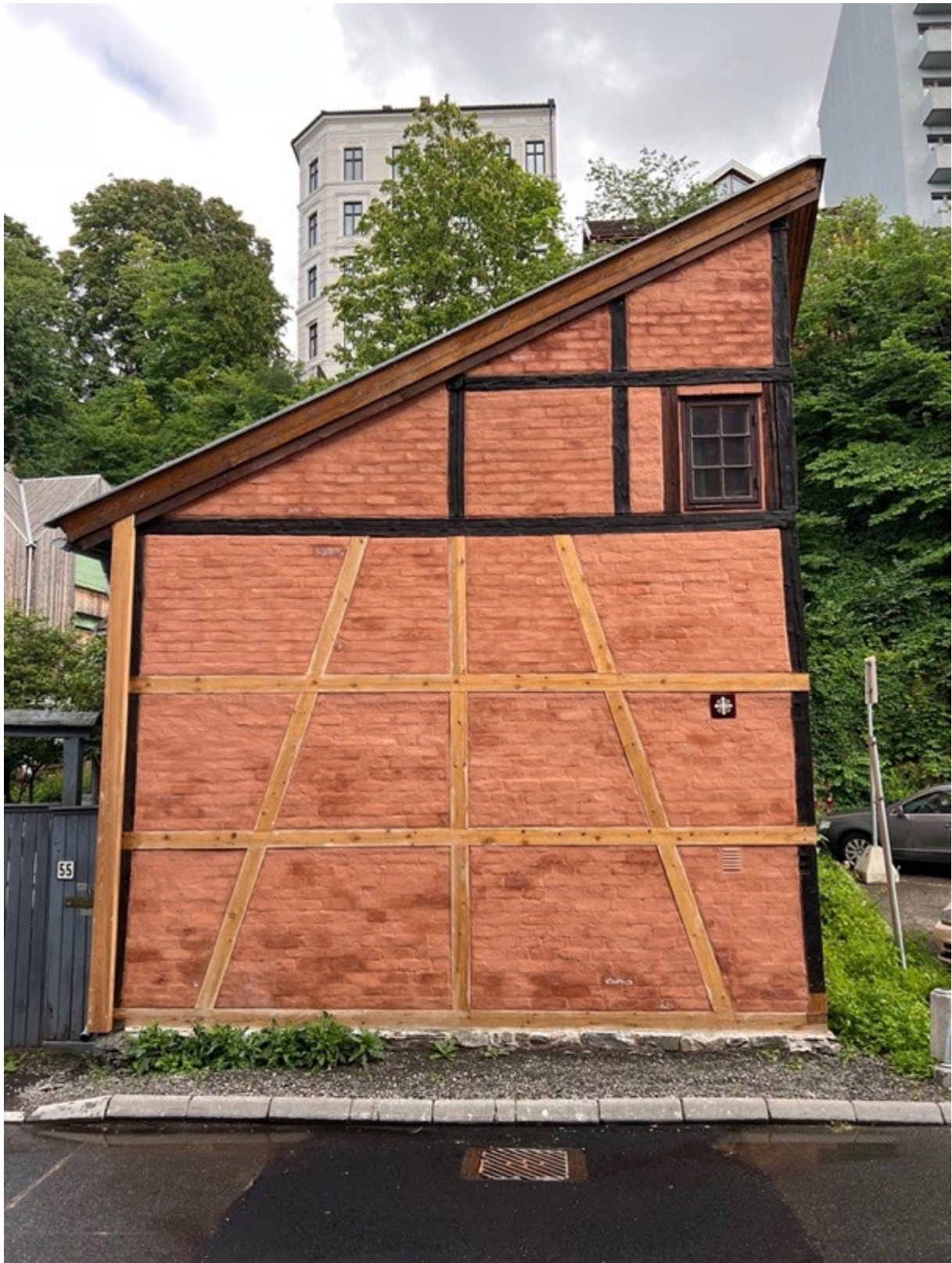
Vestveggen i Brinken 55 på Kampen ferdig restaurert. Foto 26.07.2023
