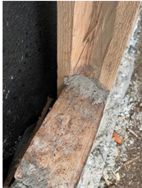
Hulkil fungerer som lås for stussfugen
