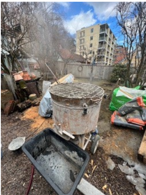
Mørtelproduksjon med tvangsblender.
