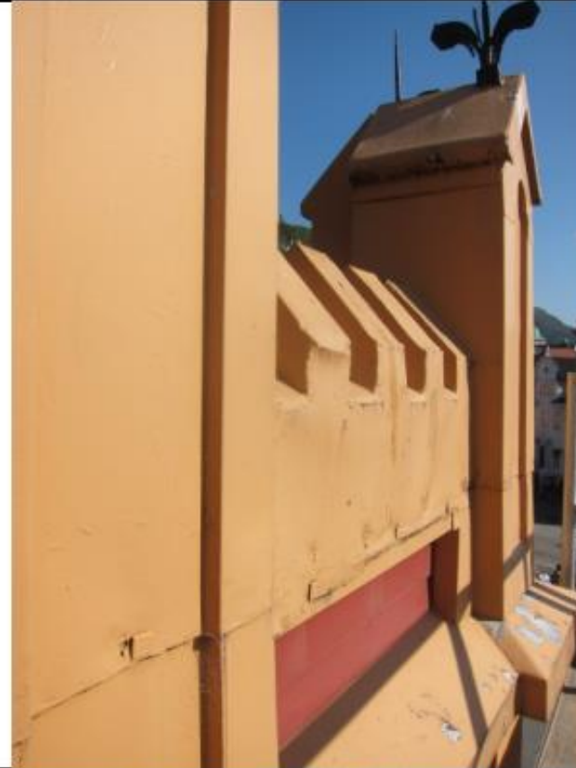
Øvre del av fasaden med metallbeslag
