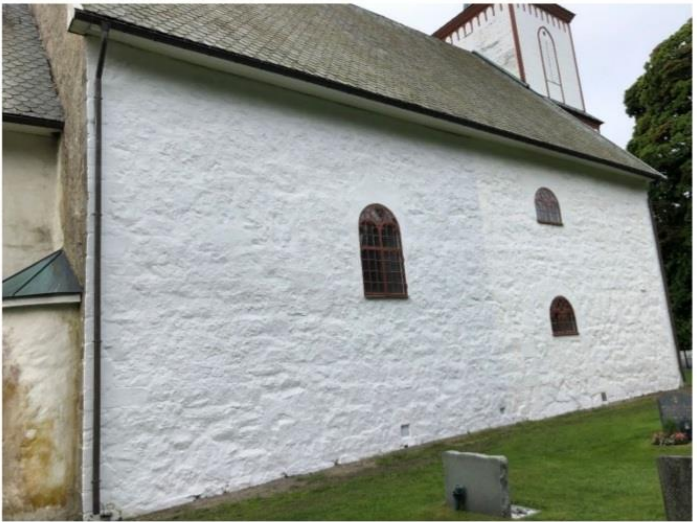
FIGUR 8. ØSTERSKALK TIL VENSTRE, RØDVG KULEKALK TIL HØYRE. (FOTO TATT I NØYTRALT DAGSLYS). FOTO: MUR OG MER, JULI 2022).
