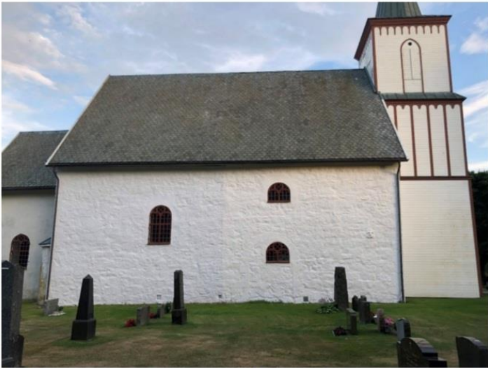
FIGUR 7. NORDVEGGEN ETTER 1. VINTERSESONG/ ET ÅR. ØSTERSKALK TIL VENSTRE, RØDVG KULEKALK TIL HØYRE. BEGGE FELT ER FORELØPIG SUTEN SKADER OG HAR LITE SMITTENDE OVERFLATER. ØSTERSKALKEN, SOM HAR MYE KULL I HVITTELAGET, FREMSTÅR SOM KALDERE MED NOE GRÅSTIKK, MENS RØDVG KULEKALK ER VARM MED NOE GULSTIKK. FOTO TATT I ET NOE VARMT KVELDSLYS. (FOTO: MUR OG MER, JULI 2022).
