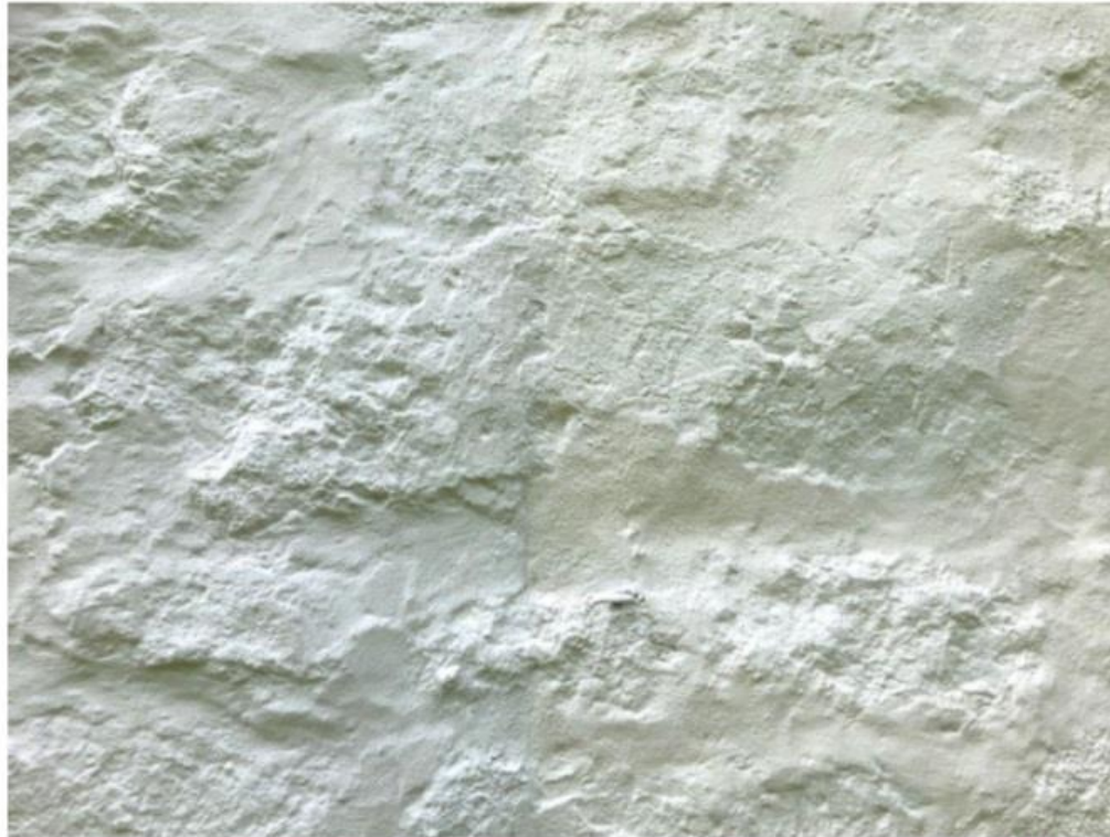
FIGUR 9. NÆROPPTAK PRØVEFELT. ØSTERSKALK T.V. RØDVIK KULEKALK T.H. (FOTO: MUR OG MER, JULI 2022).
