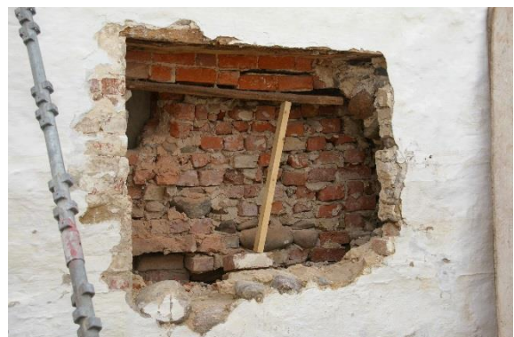
Fig. 7. Muremørtel mellem teglsten, skib lukkemur i norddør
