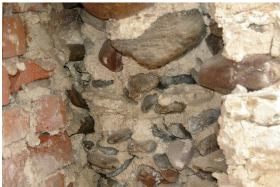
Fig. 4. Mørtel mellem granitsten inderst i kassemur, skib nordvæg, 1200
