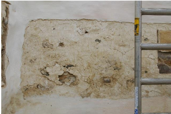
Fig. 2. Pudsmørtel, kor nordvæg, 1200
