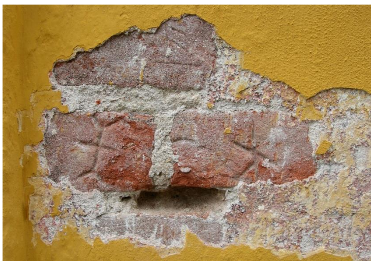
Fig. 14. Rørvig Kirke. Middelaldermurværk bag senere puds. Bemærk teglmestermærkerne på munkestenene
