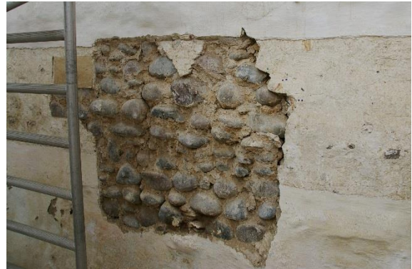
Fig. 3. Muremørtel mellem granit natursten, kor nordvæg, 1200
