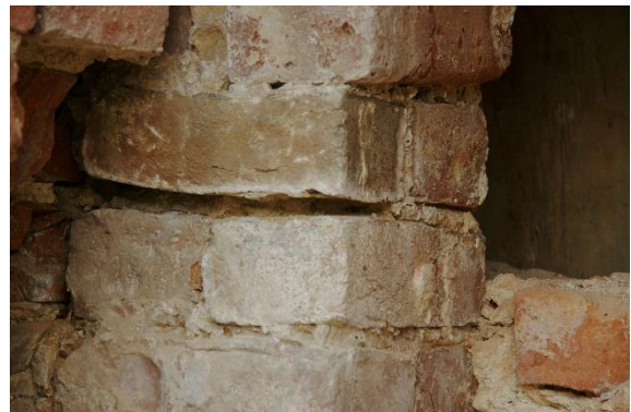
Fig. 5. Muremørtel mellem teglsten, skib norddør
