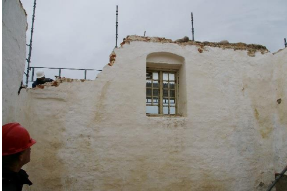
Fig. 8. Muremørtel mellem teglsten, vestgavl, 1700
