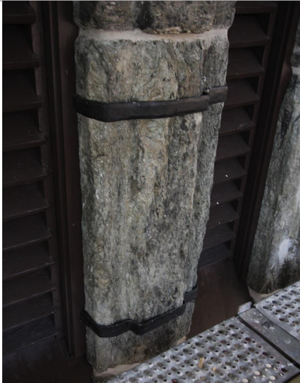
Ved skader på kleberstein Vi limte, vi skiftet ut, vi bygget på med kalk, eller .....
