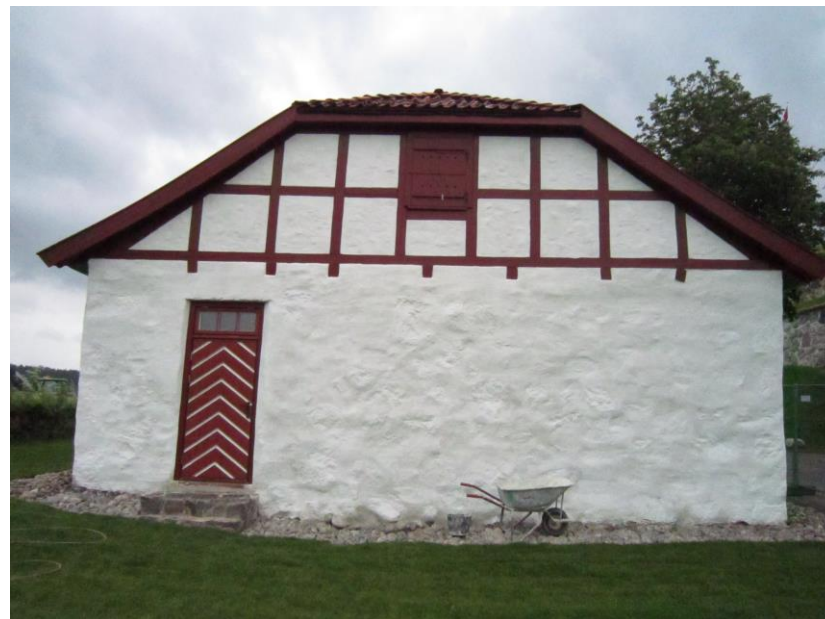
Søndre gavl ferdig med nytt bindingsverk, hvittede vegger og nyoppmalte detaljer (08.06.2011)
