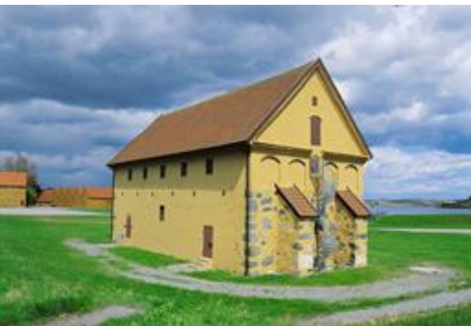
KRUTTHUSET PÅ FREDRIKSVERN VERFT REHABILITERT I 2012
