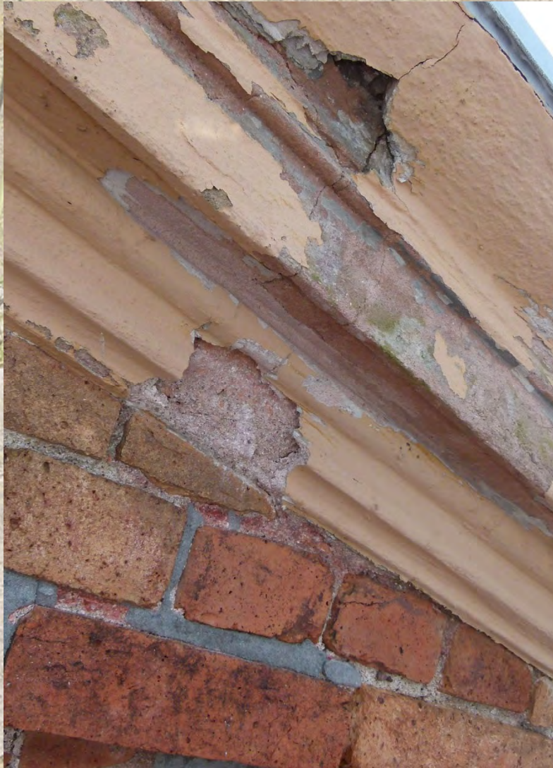
Hasle Gamle Raadhus , opført 1855 - gesims
