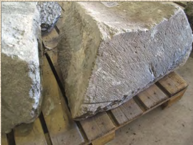
Randhogging for å jevne ut overflaten
