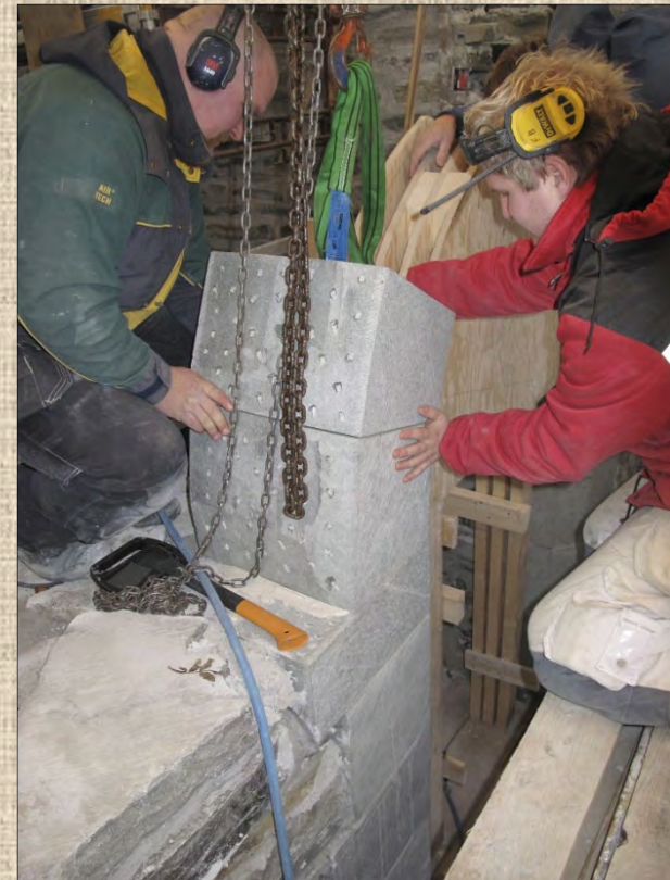
Løfteteknik av stein til bue.
