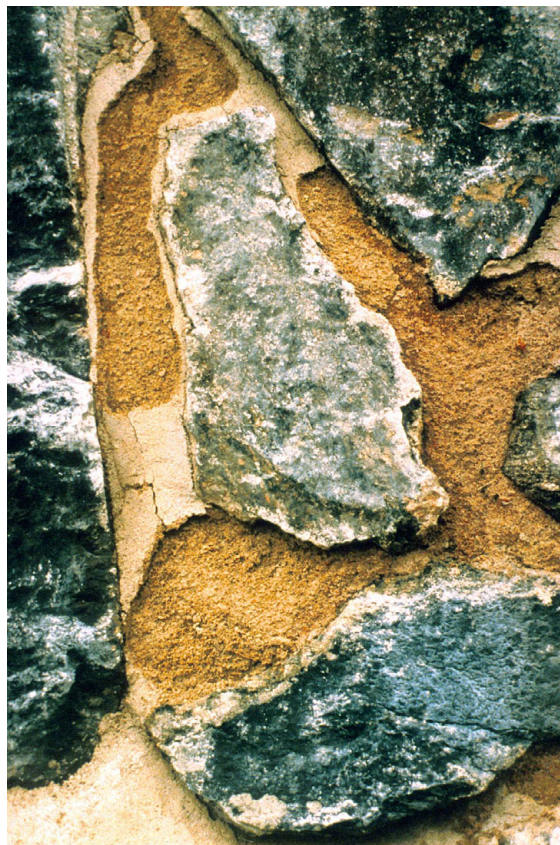
↑ Foto 3: Efter den første vinter var den yderste del af mørtelfugerne skallet af.
