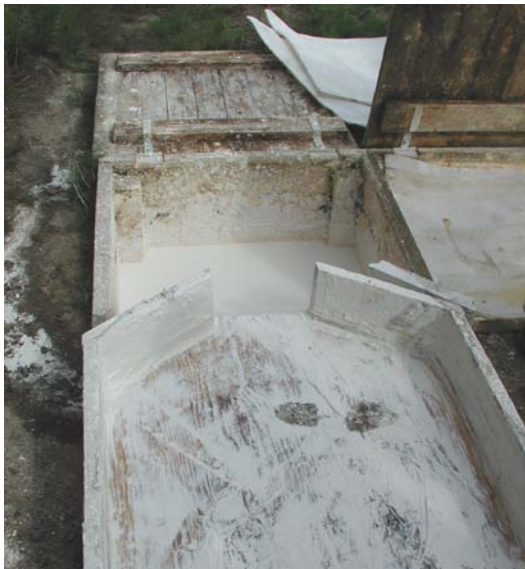
Læskning til træforet jordkule, i Den gamle by i Aarhus. Vandet fra kalkvællingen siver ud i jorden, og der dannes den tykke kalkdej, som helst skal lagre i mindst 2 år.
