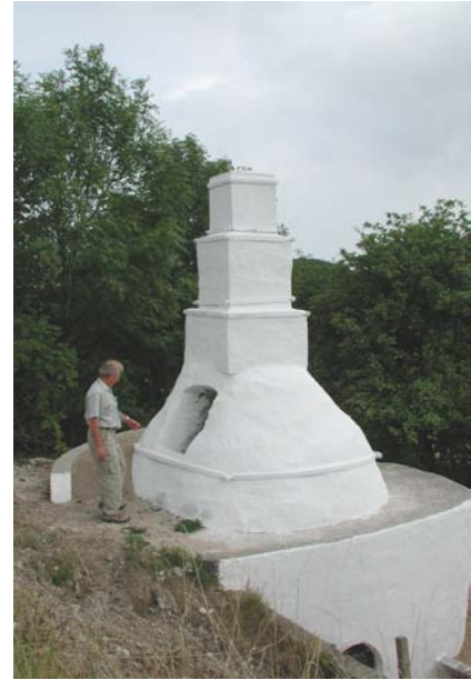
Tre små kuplede kalkovne i Birkesig på Djursland til periodisk brænding, Opført 1925 og brugt frem til ca. 1940. Tegning, ark.maa Nik. Hyllestad, 1999. Foto, NHL, 2002, efter restaurering.
