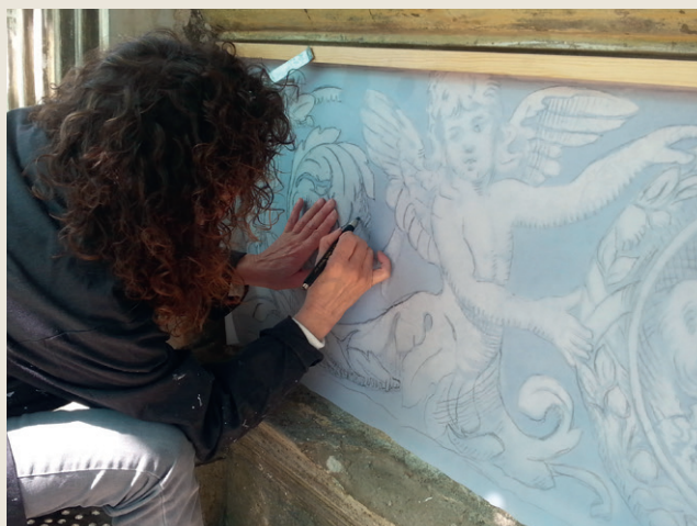
Motivene ble avtegnet i 1:1 på plastbelagt kalkerpapir
