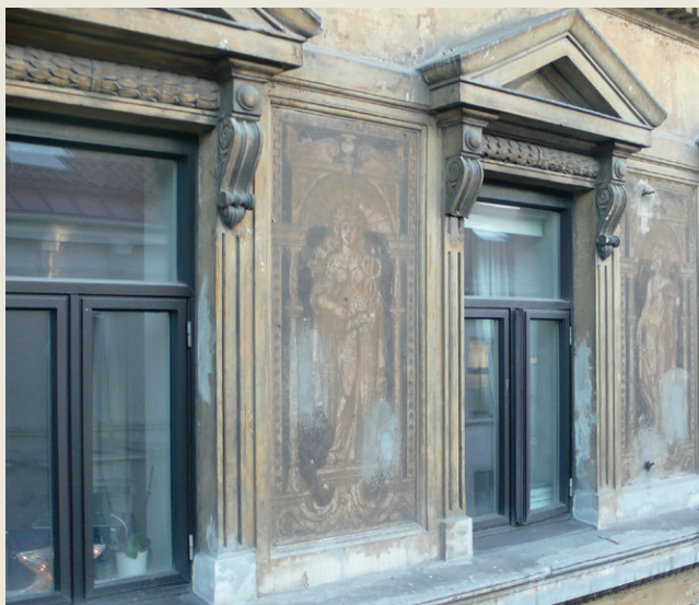
Tilstand før restaurering: Sgraffito-felt i 4. etasje
