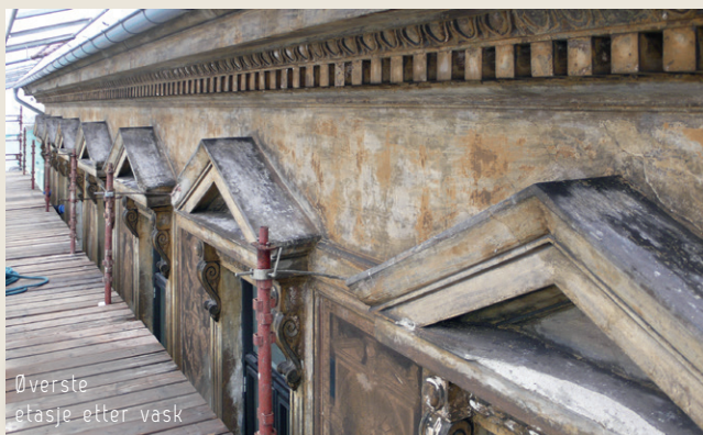
Sementbasert pussmørtel utenpå gipstrekkninger
