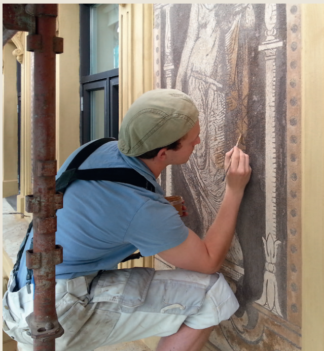
Giacomo retusjerer. Det jobbes vått-i-vått: sgraffitoflatene ble forvannet og ettervannet med kalkvann
