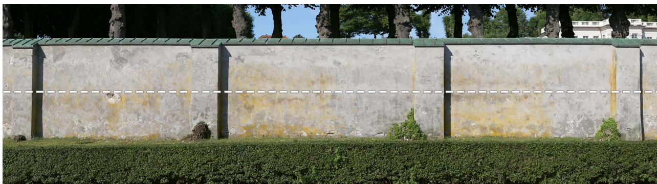
Foto 1: Murens yderside i området med prøvefelterne. I murens inder-side er de nederste 1,5 meter dækket af jord (kote markeret med stiplede linje). De 3x3 meter store prøvefelter er placeret parvis mellem murens støttepiller. Marienlyst Slot kan skimtes bag muren i baggrunden til højre.
