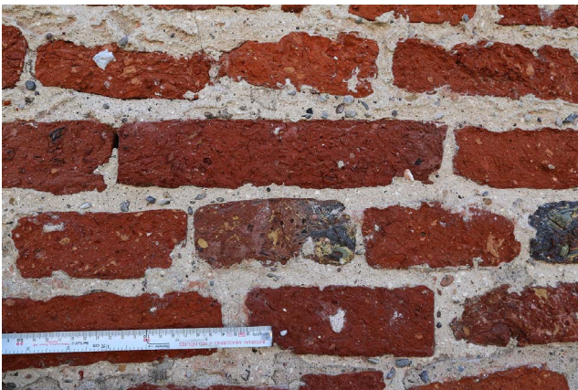
Foto 3 og 4: Udsnit af den afrensede mur. Til opmuringen er der anvendt en bindemiddelrig, meget grovkornet mørtel. Efter opmuringen har mørtelen i større eller mindre grad dækket stenenes overflade (tv).
