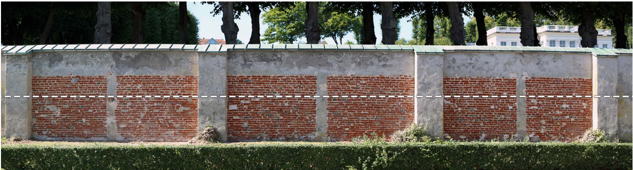
Foto 2: Murens yderside efter afrensning af puds, kalk- og farvelag i de 6 prøvefelter. Koten for jorddækningen i murens bagside er markeret med stiplede linje.
