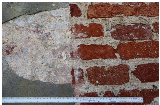
Foto 5: Kanten af et af de afrensede murfelter. Under den yderste cementholdige puds ses ældre hvide, rødlige og grålige kalk- og farvelag.
