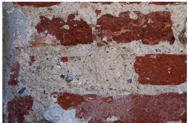
Foto 3 og 4: Udsnit af den afrensede mur. Til opmuringen er der anvendt en bindemiddelrig, meget grovkornet mørtel. Efter opmuringen har mørtelen i større eller mindre grad dækket stenenes overflade (tv).
