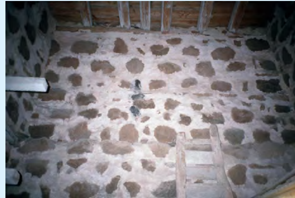
Mur- och fogbruk. Brunaktigt. Kalk med hydrauliska kalkklumpar från orsten från Andrarum. Subhydrauliskt. H_m = 0,26 .
