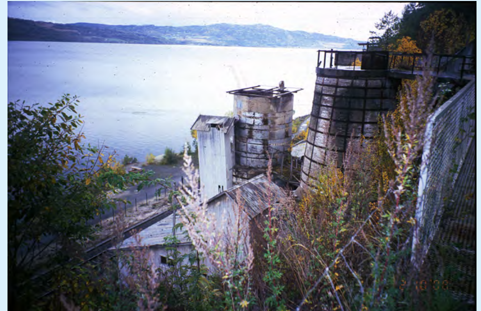
Steens kalkbruk i Furuberget vid Hamar (1894-1977). Här tillverkades den sista hydrauliska kalken i Norden.
